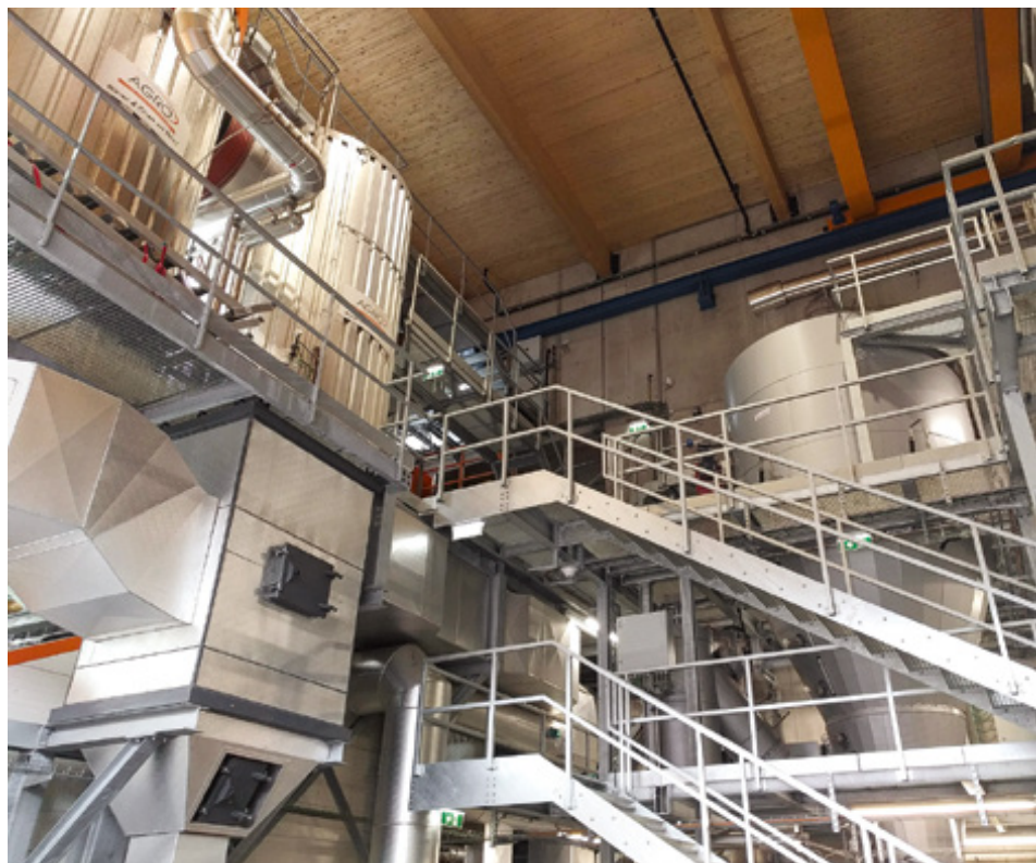
△ Ilgs Maschinenhalle mit Biomassekessel (li.) und dem Reaktor für die Kohleproduktion (re.)
